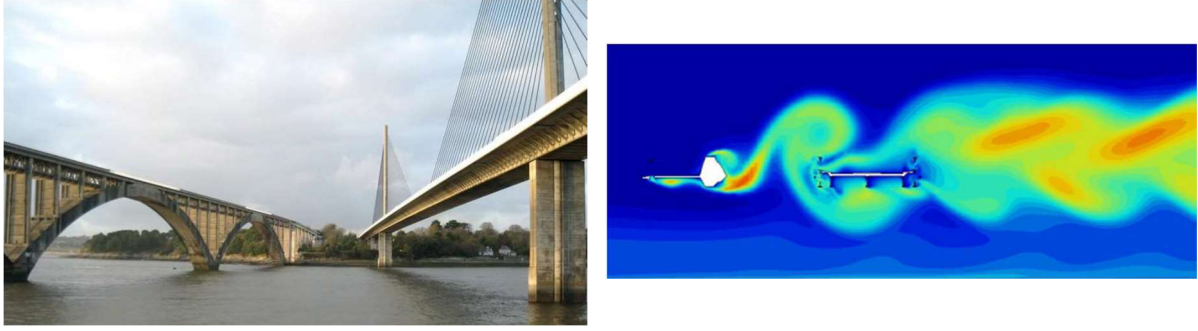
Figure 9. L'influence d'une structure voisine (© Bouygues TPRF / Optiflow)
