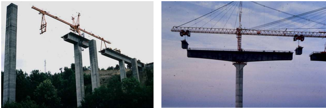
Figure 56. Quelques ponts construits par encorbellements successifs
